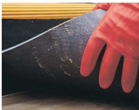
Application de revêtement en caoutchouc avec Adesilex LP sur un escalier
