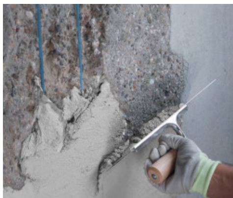
Application à la taloche de Planitop Rasa & Ripara
