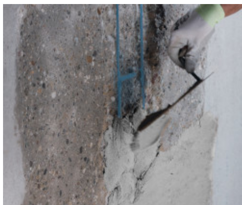
Application à la truelle de Planitop Rasa & Ripara
