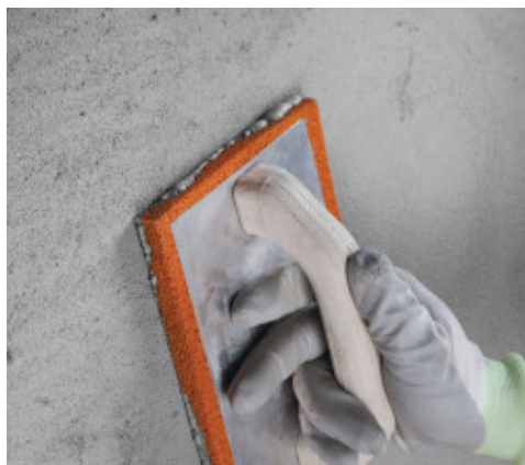
Talochage de Planitop Rasa & Ripara
